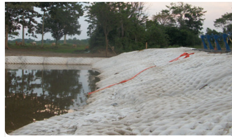
▲ Protección de estructuras hidráulicas.
